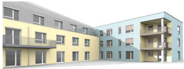
Die neue Fassade Rolandstraße 17a: Die grafische Vorlage für den Anbau wird schon bald Realität sein, auch farblich.
