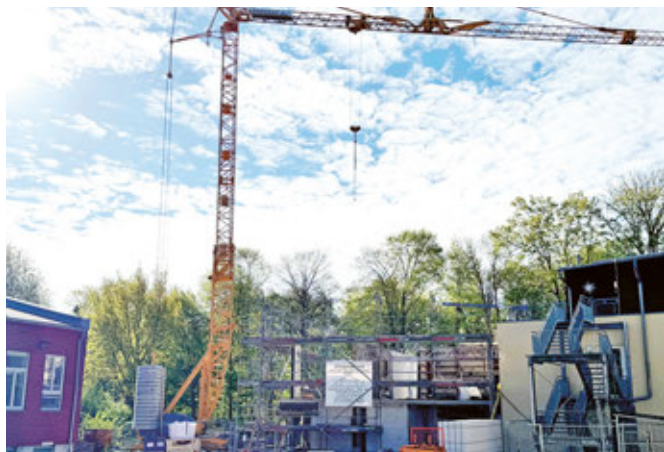
So sah die Baustelle Rolandstraße 17a am 4. Mai 2026 aus.
