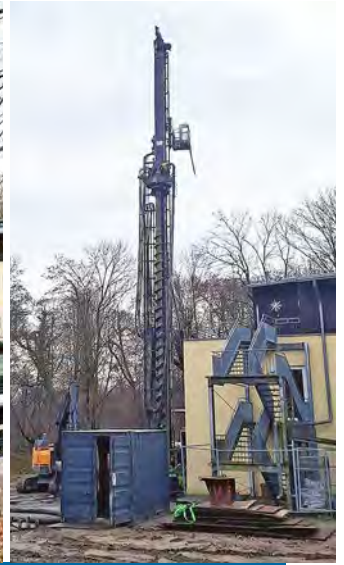
Ein großer Bohrer machte tiefe Löcher für Pfähle aus Beton.
