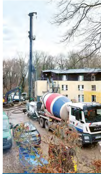
Ein großer Bohrer machte tiefe Löcher für Pfähle aus Beton.
