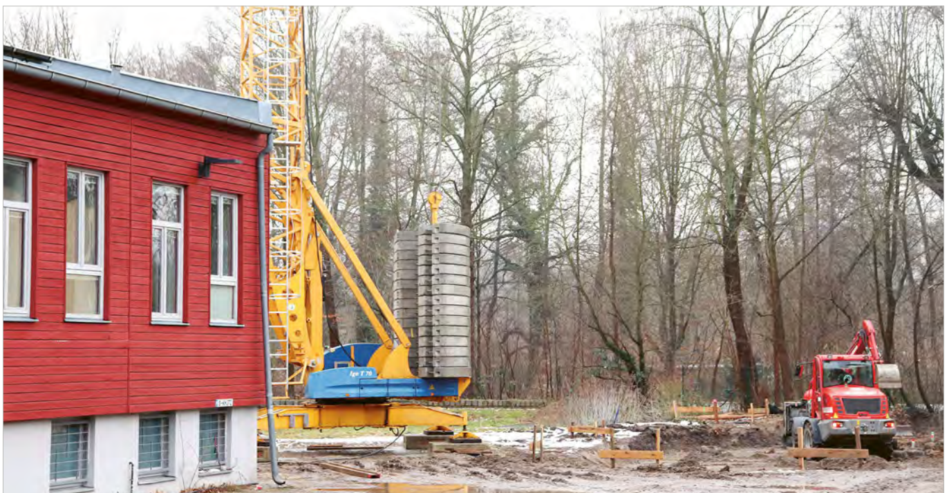
Baugelände vom Neubau Haus 6 (links Bestand Haus 4)
