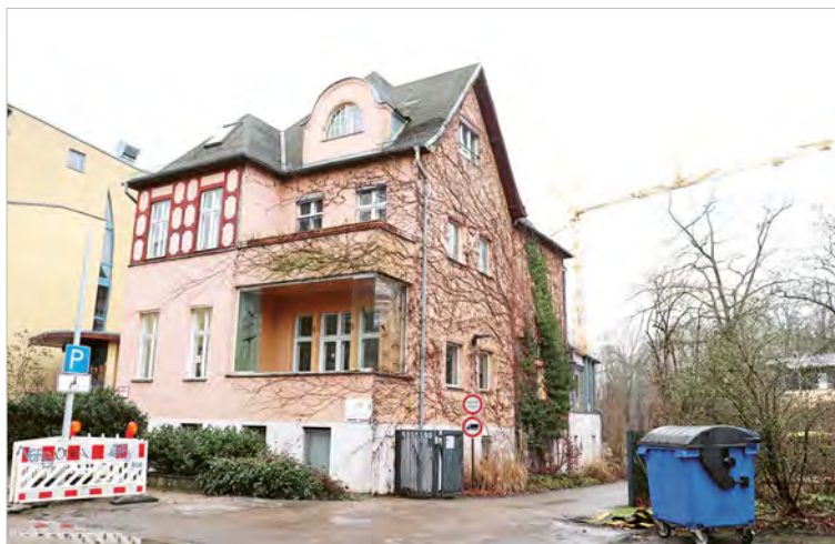
Straßenansicht Villa vor dem Rückbau
