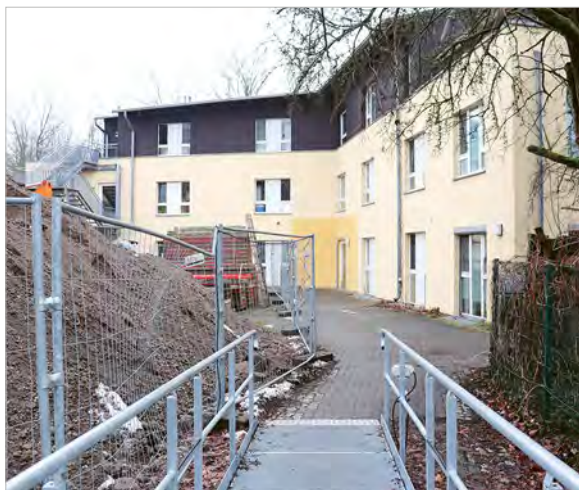
Zugang Wohngebäude Bestand Haus 5
