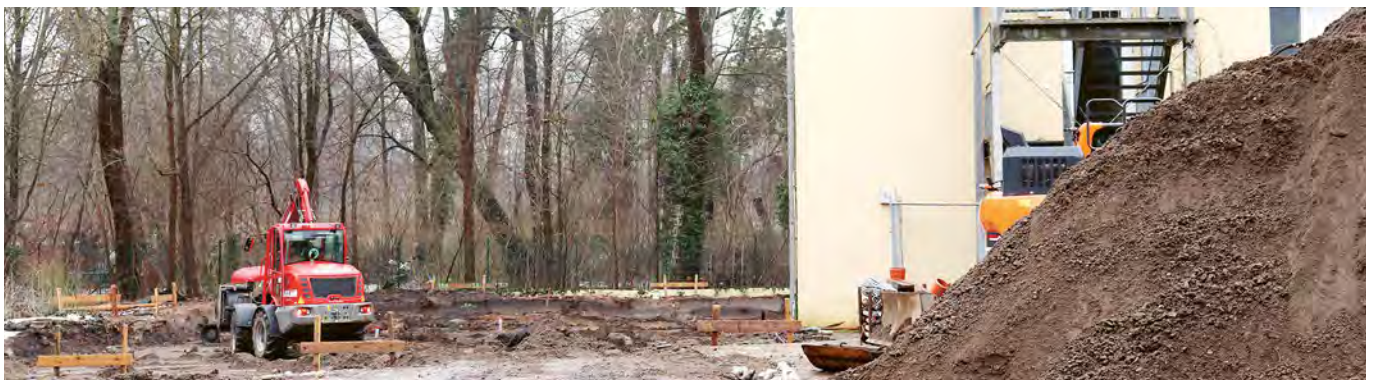
Baugelände vom Neubau Haus 6 (rechts Bestand Haus 5)
