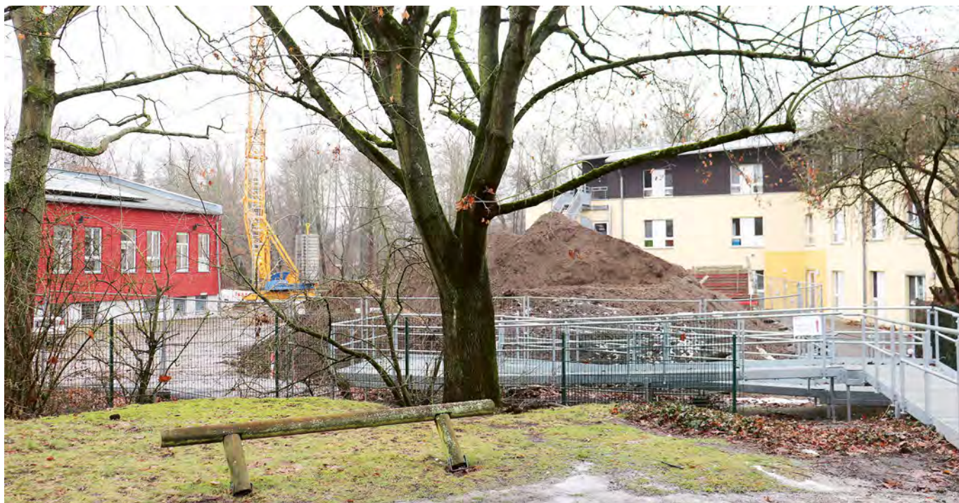
Blick von der Rolandstraße auf die barrierefreie Rampe mit Bestand Haus 4 (links) und Haus 5 (rechts)
